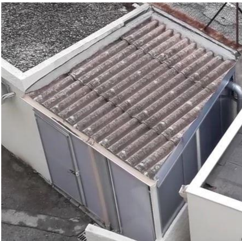
Atelier 2 (Enveloppe extérieure) - Toit - Plaques ondulées fibrociment
