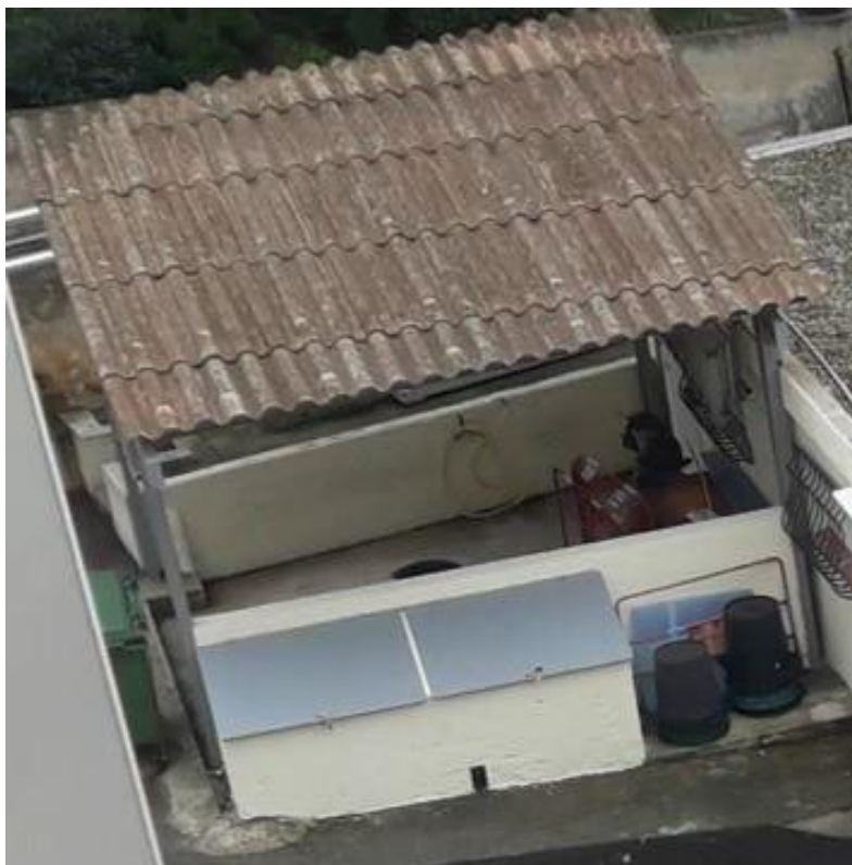
Préau atelier 1 (Enveloppe extérieure) - Toit - Plaques ondulées fibrociment
